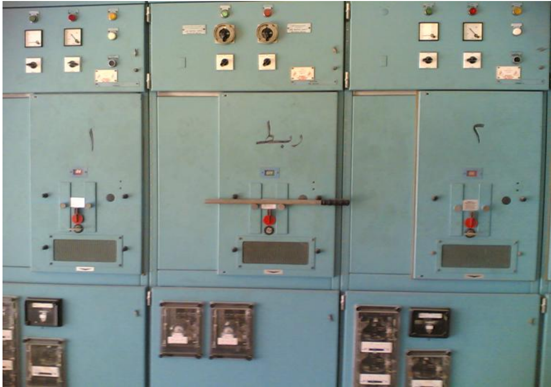
لوحة توزيع موضح بها خطى الدخول وخلية الربط
