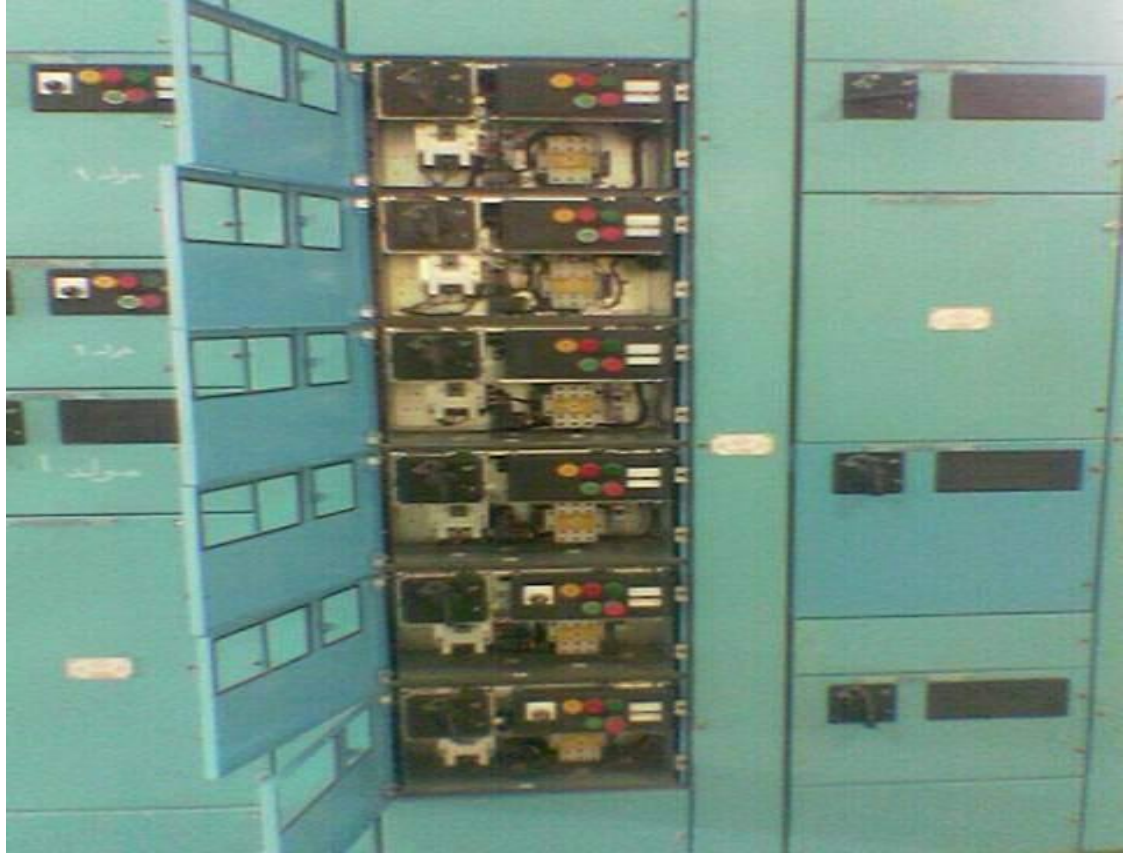
الشكل يوضح لوحة جهد منخفض بخلايا منزقة
