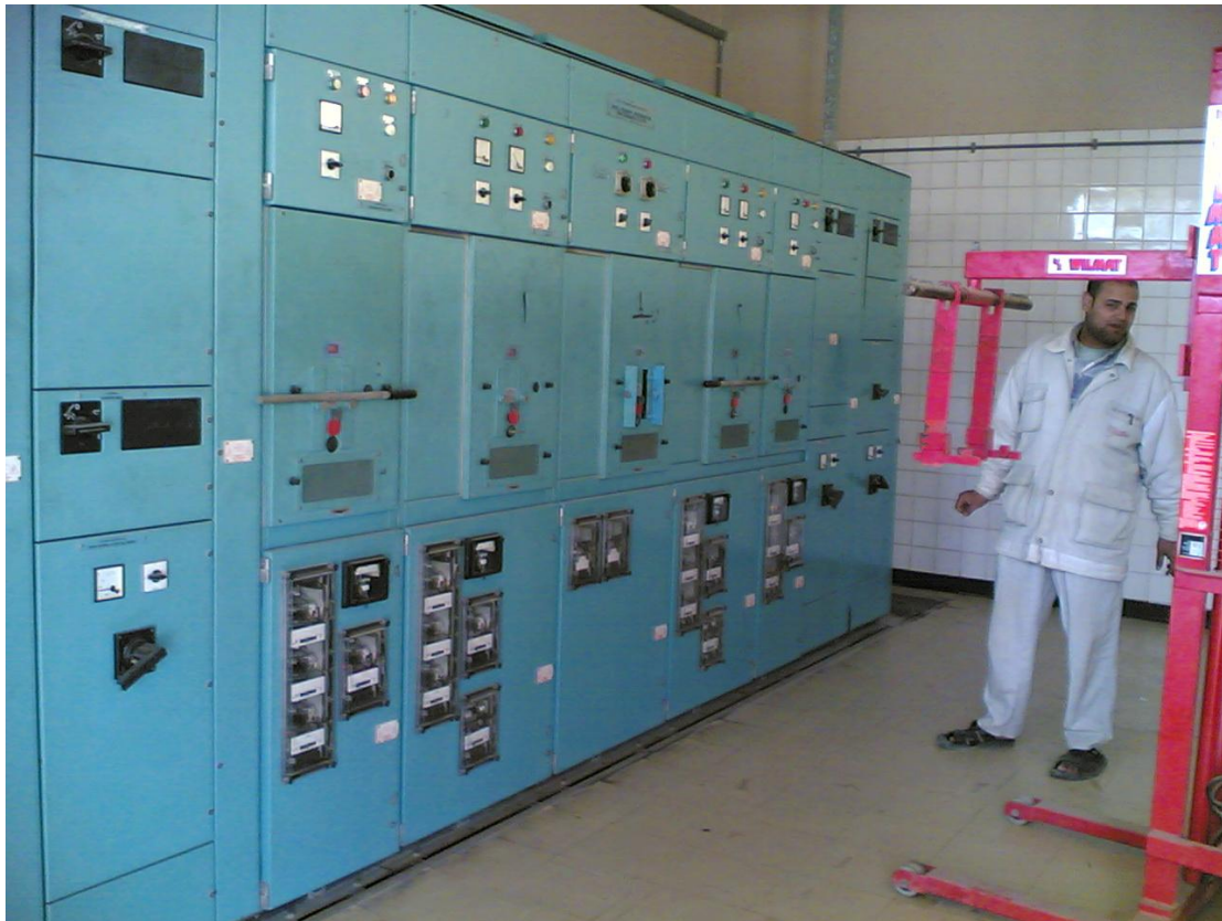
الشكل يوضح لوحة توزيع جهد منخفض اثناء اجراء صيانة باستخدام ونش تحميل القواطع
