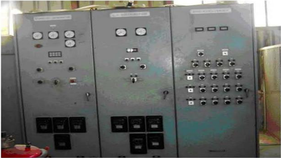
لوحة جهد منخفض تتغذي من مولد وتوزع التيار إلى الأقسام المختلفة
